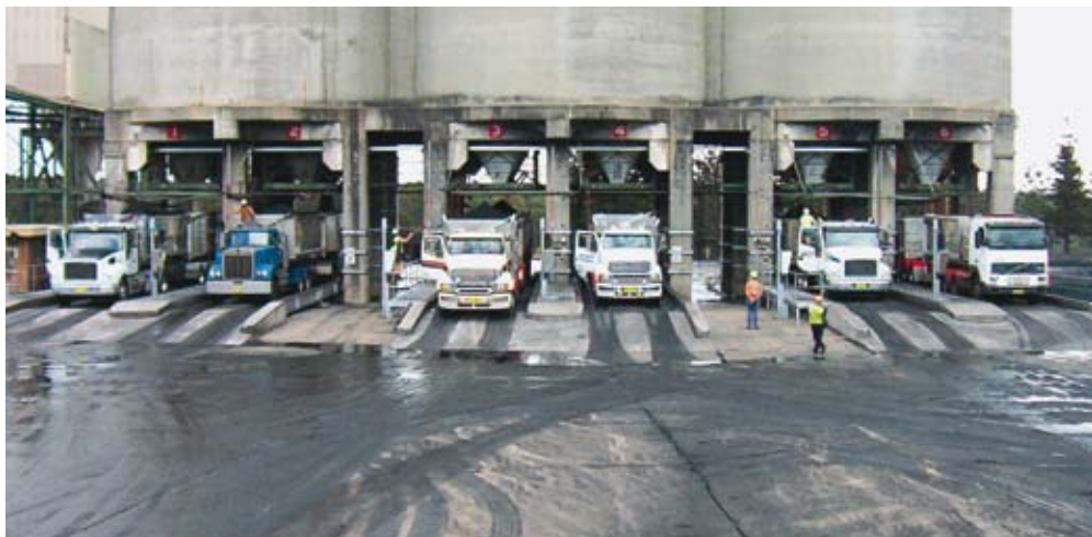
Pal onder de productsilo's van de fabriek werden zes nieuwe weegbruggen geïnstalleerd.
