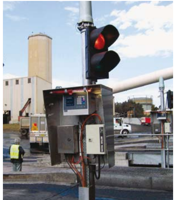
JAGXTREME®-terminals stellen de vrachtwagenchauffeurs in staat om het voertuiggewicht te valideren tijdens het laden.
