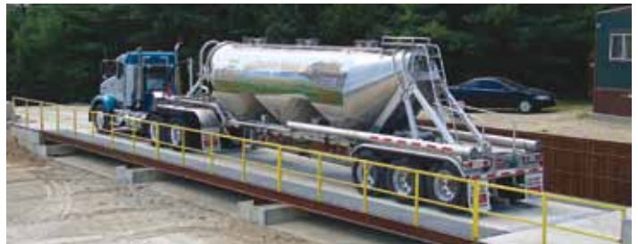
Faciliteit voor voertuigwegingen van binnenkomende en uitgaande goederen met behulp van één weegbrug
